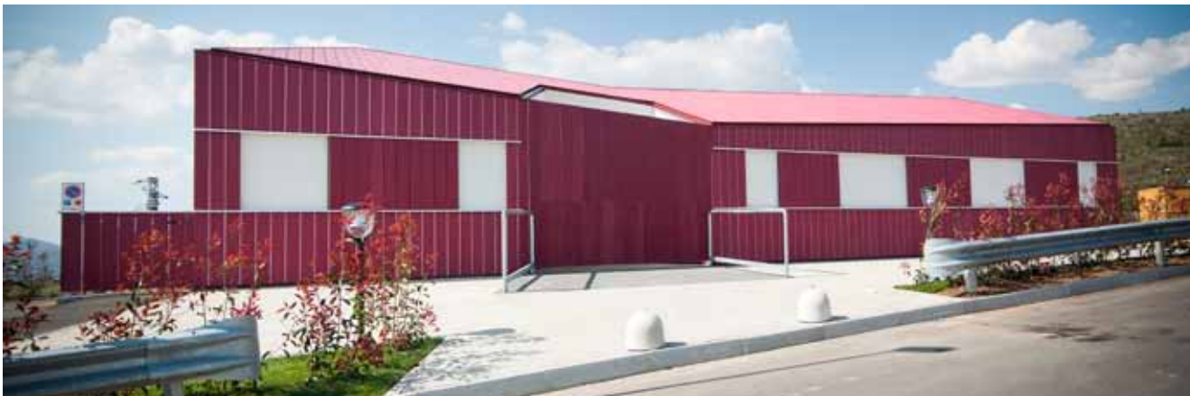
Con gli scuri scorrevoli a coprire le parti finestrate, si continua a leggere, senza disturbo, la continuità del rivestimento (in alto) The continuity of the coating is perceivable even when the window dimmers are totally closed (above) Fase di ultimazione del rivestimento esterno (in basso) Completion external coating (below)
